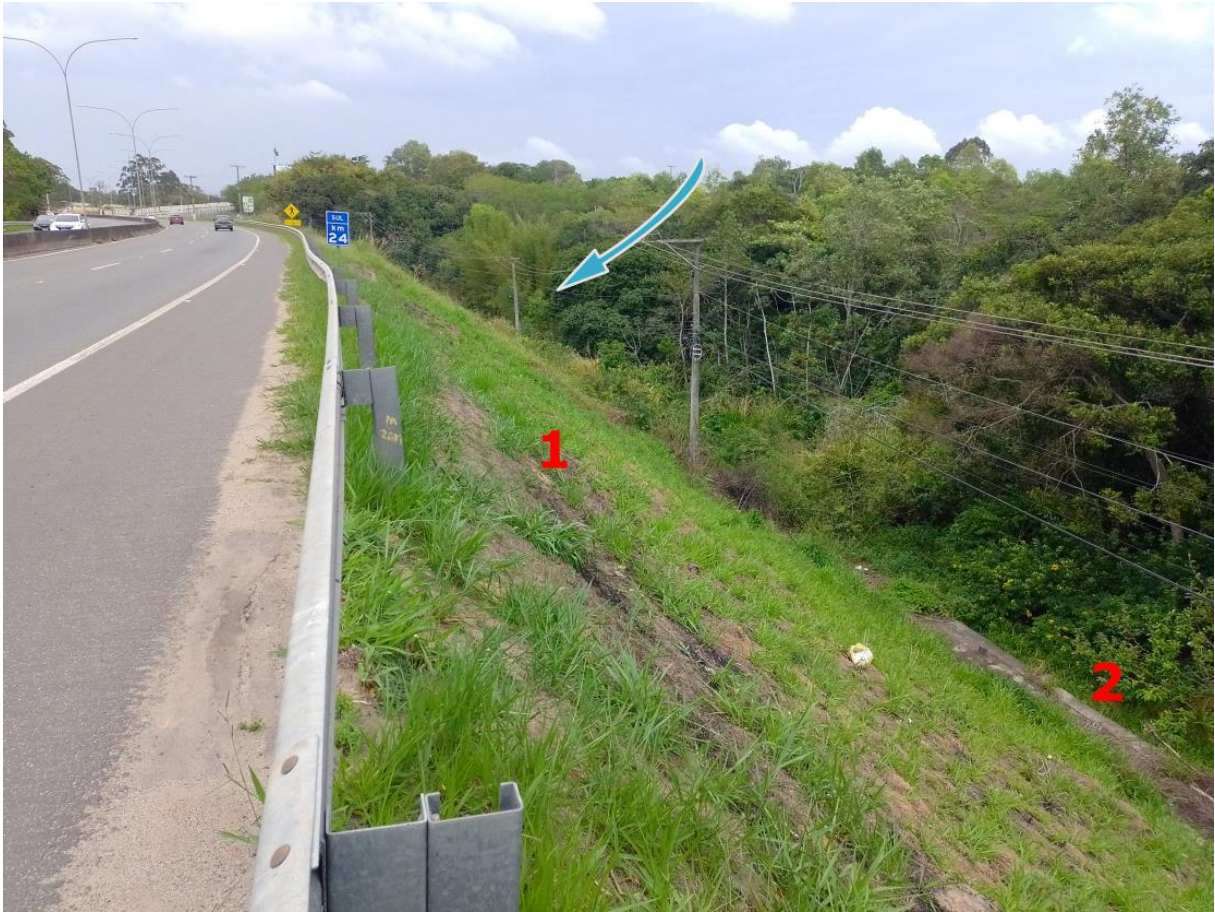
Figura 20 — Trecho da Rodovia ES-060 com função de dique.
